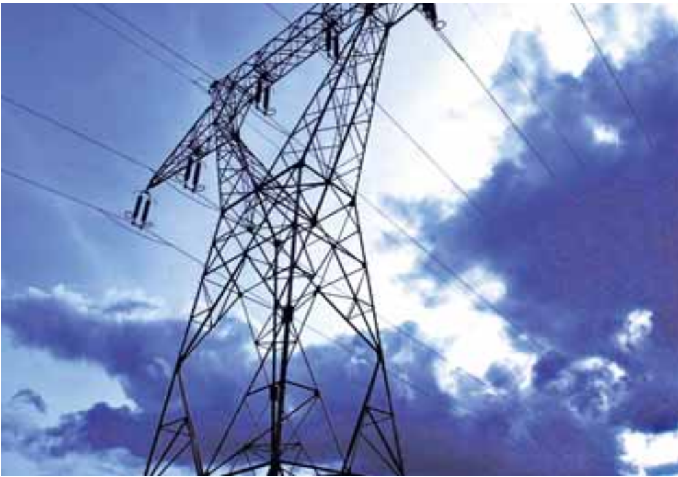
Da braut sich etwas zusammen: die 380-kV-Leitung in der Steiermark soll unter die Erde
